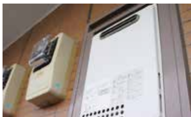
가스 연소장치의 미소전류측정에 DCμA레인지 (DT4253만 해당)
